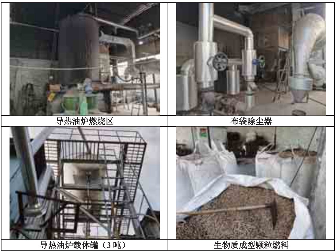
图 2.13-3 现有项目导热油炉废气收集/处理设备现状图
